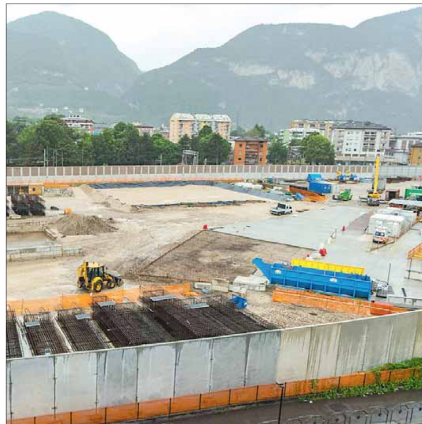
In alto da sinistra il medico Paolo Bortolotti e l'area di cantiere a Trento Nord
