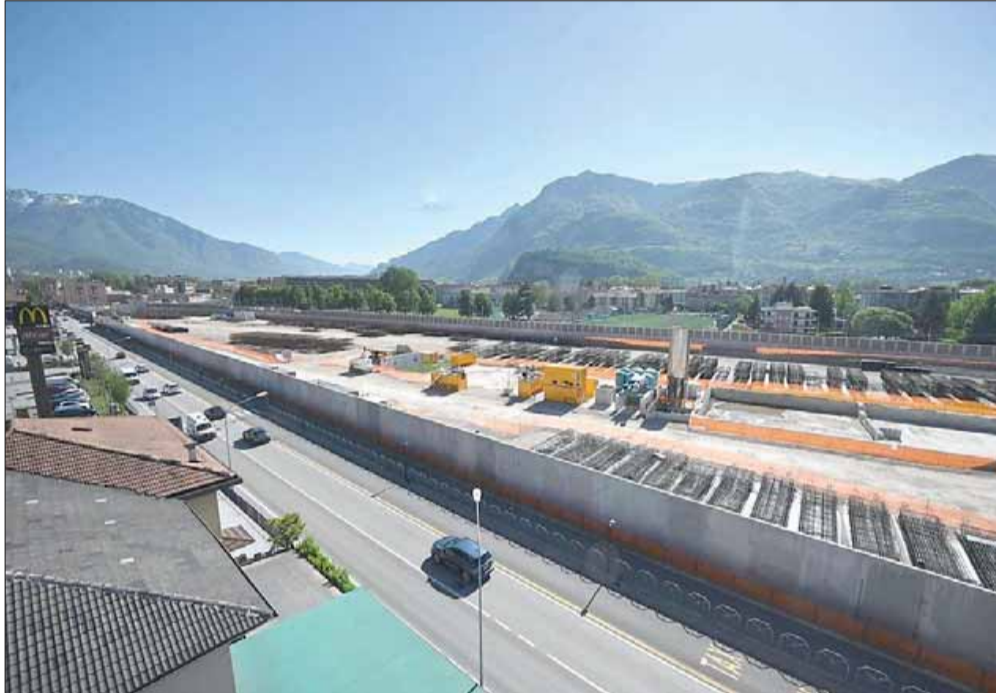
Il cantiere all'altezza dello Scalo Filzi, ordinato e deserto da mesi (fotografie di danielle Panato)
