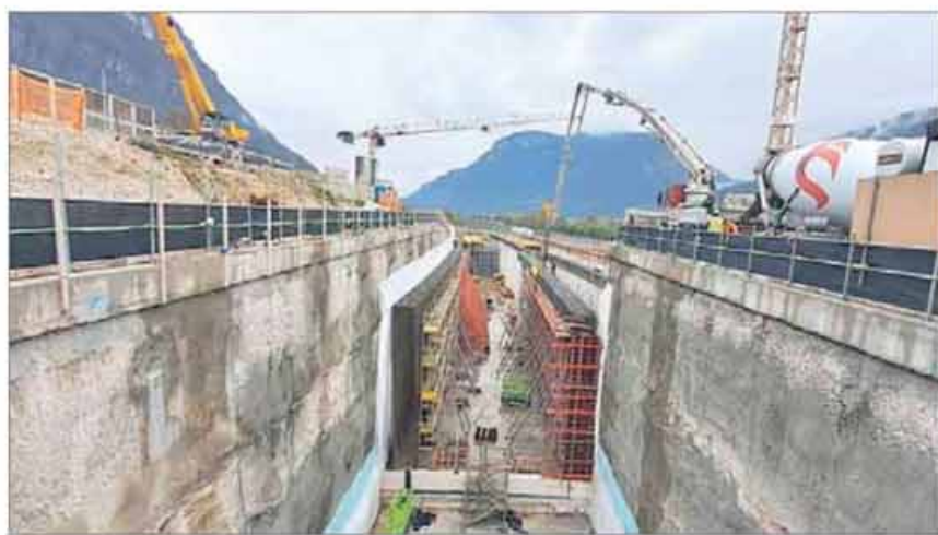
Il cantiere a sud per la realizzazione del bypass ferroviario
