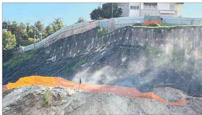
Entro l'anno finiranno a nord i lavori di consolidamento del versante roccioso di via Pietrastretta
