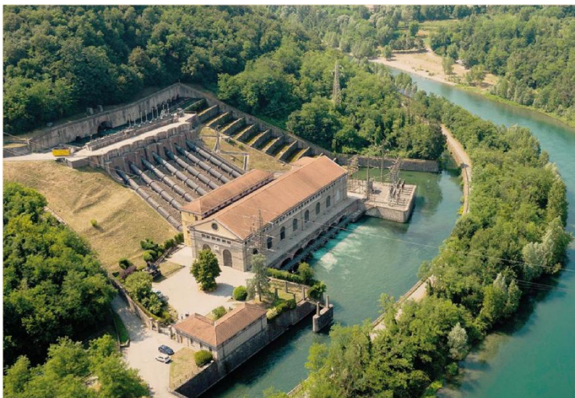
Il nodo concessioni. La centrale idroelettrica Angelo Bertini a Porto d'Adda
