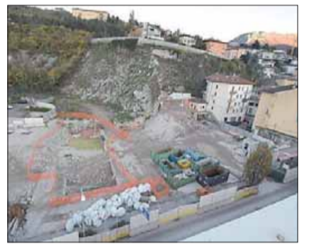
Il cantiere all'imbocco nord in S. Martino
