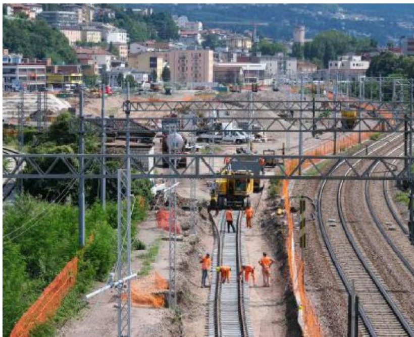
Ferrovia I lavori del nuovo bypass ferroviario di Trento
