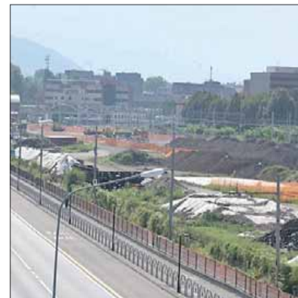
L'area dei lavori nella zona dello Scalo Filzi
