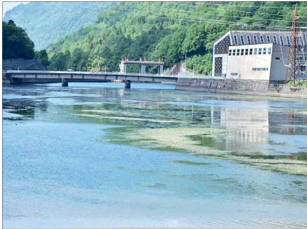
La Provincia ha legiferato di prorogare dal 2024 al 2029 le concessioni idroelettriche: stop dello Stato
