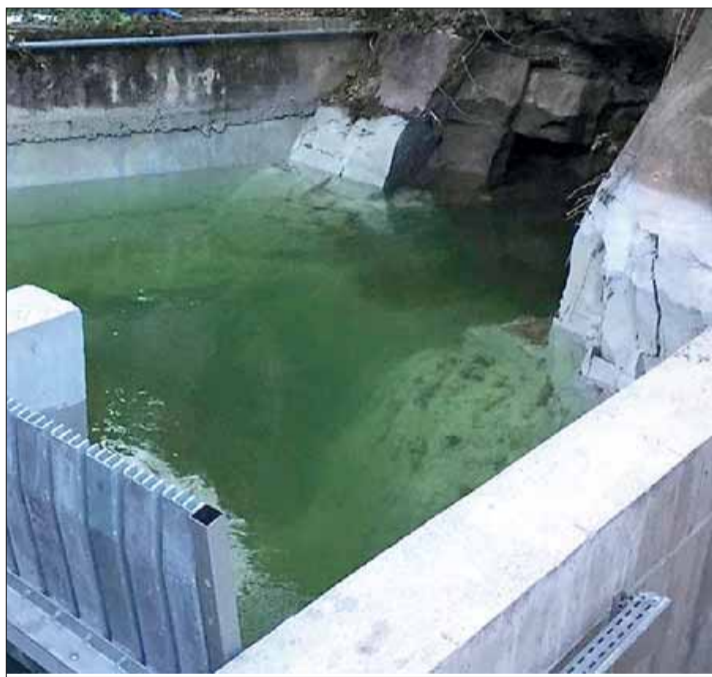
Una piccola derivazione idroelettrica sul torrente Avisio
