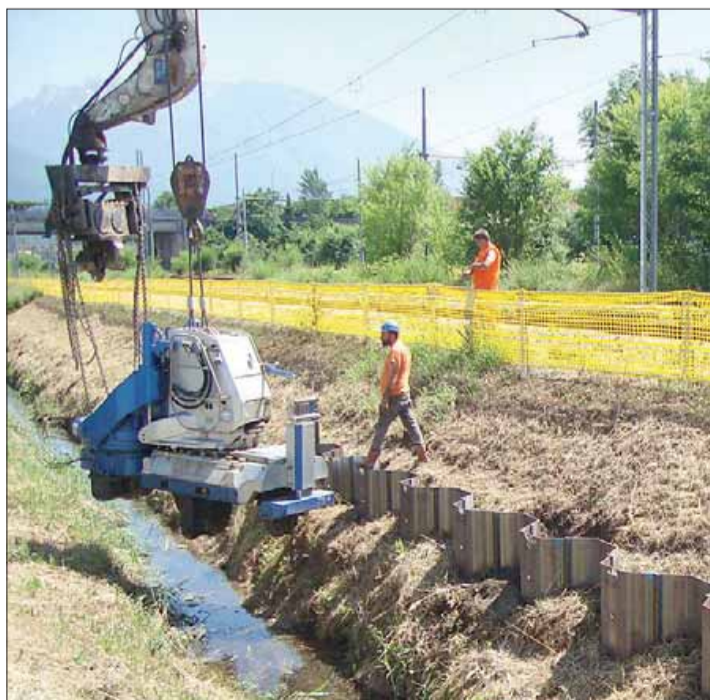
I lavori di preparazione allo scavo lungo il rio Lavisotto
