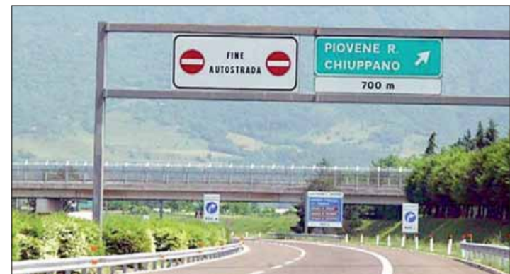
In alto i lavori al tunnel del Brennero, qui sopra la Valdstico
