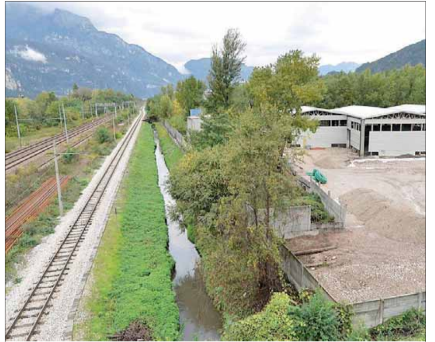
Ferrovia e roggia nella parte sud dell'ex Carbochimica
