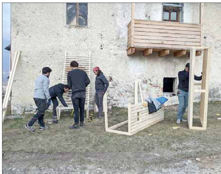
Gli studenti del Politecnico al lavoro sui moduli abitativi
