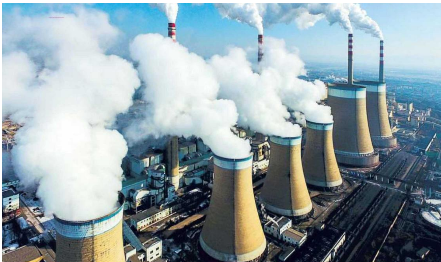
Il fumo dalle ciminiere di una centrale elettrica a carbone nella città di Datong, nella provincia dello Shanxi nella Cina settentrionale
