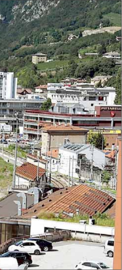
edifici saranno abbattuti (foto Pedrotti)
