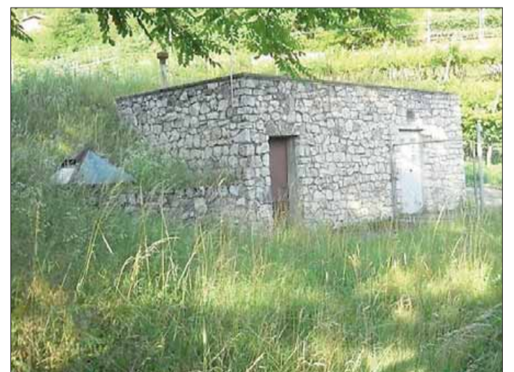
Una delle centraline nei pressi del torrente Arione, ad Aldeno
