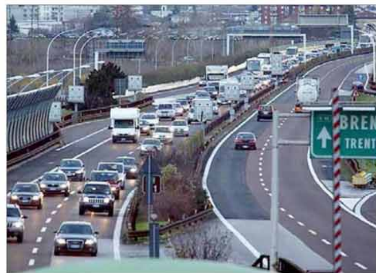
I tempi pre Covid, quando sull'autostrada A22 c'era un traffico intenso
